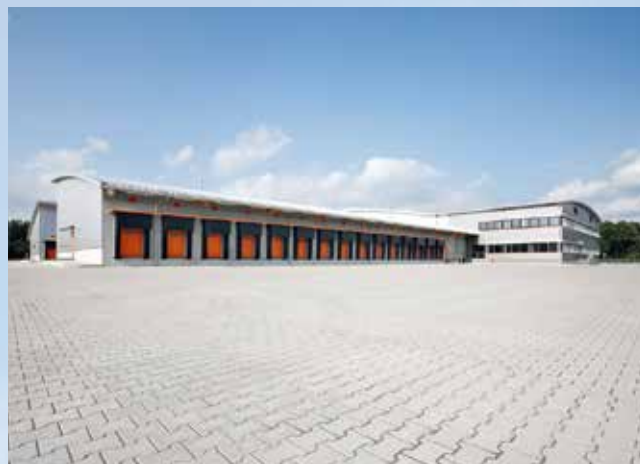
Der Hallengrundriss zeigt nicht einen klassischen Quader, sondern hat die Form eines „Y“. Auf diese Weise können auf gleicher Hallenfläche mehr Fahrzeugtore gebaut werden.
