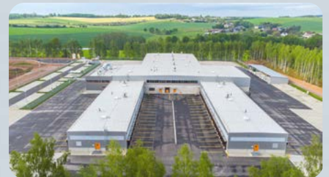
Das Luftbild macht das kompakte und effiziente Anlagendesign deutlich: Die beiden Ladefinger unten für Zustellfahrzeuge und der breitere Ladefinger oben für die großen Langstrecken-Lkw bilden ein Y. Diese Form minimiert den Rangierraum und ermöglicht auf einer relativ kleinen Fläche viele Ladetore sowie ein schnelles Cross-Docking zwischen den Bereichen Langstrecke und Letzte Meile.
