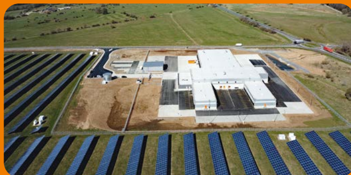
Das neue trans-o-flex-Logistikzentrum im hessischen Driedorf liegt direkt neben einem Solarpark. Seit 2008 bezieht das Unternehmen fast seinen gesamten Strom aus regenerativen Energien.
