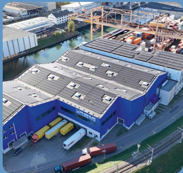
Komplett mit Solarpanelen belegt ist das Dach des neuen Bonafide-Standorts in Basel. Am Rheinhafen konnte Bonafide nach der Übernahme durch Rhenus in deren Logistikzentrum ziehen.
