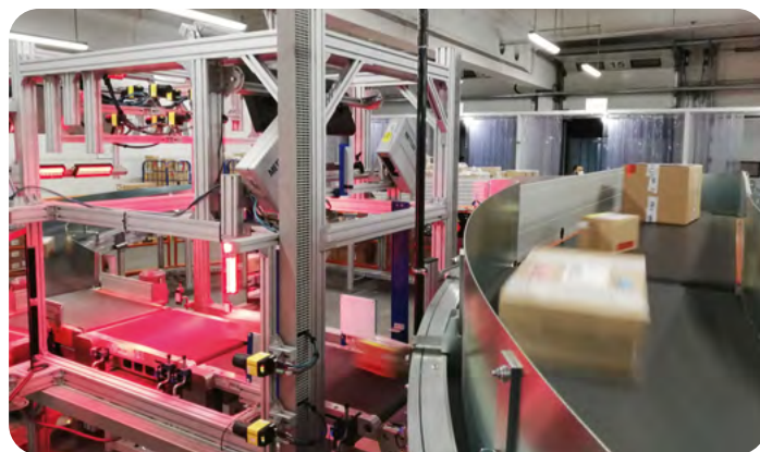
Wesentlicher Faktor für die Beschleunigung des Umschlagbetriebs in Baunatal ist der Einbau einer automatischen Sortieranlage.
