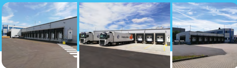
Das Hub von trans-o-flex ThermoMed erhält durch einen Hallenanbau zusätzliche Be- und Entladetore, mehr Umschlagfläche und eine vollautomatische Sortieranlage. Derzeit läuft der Innenausbau.
